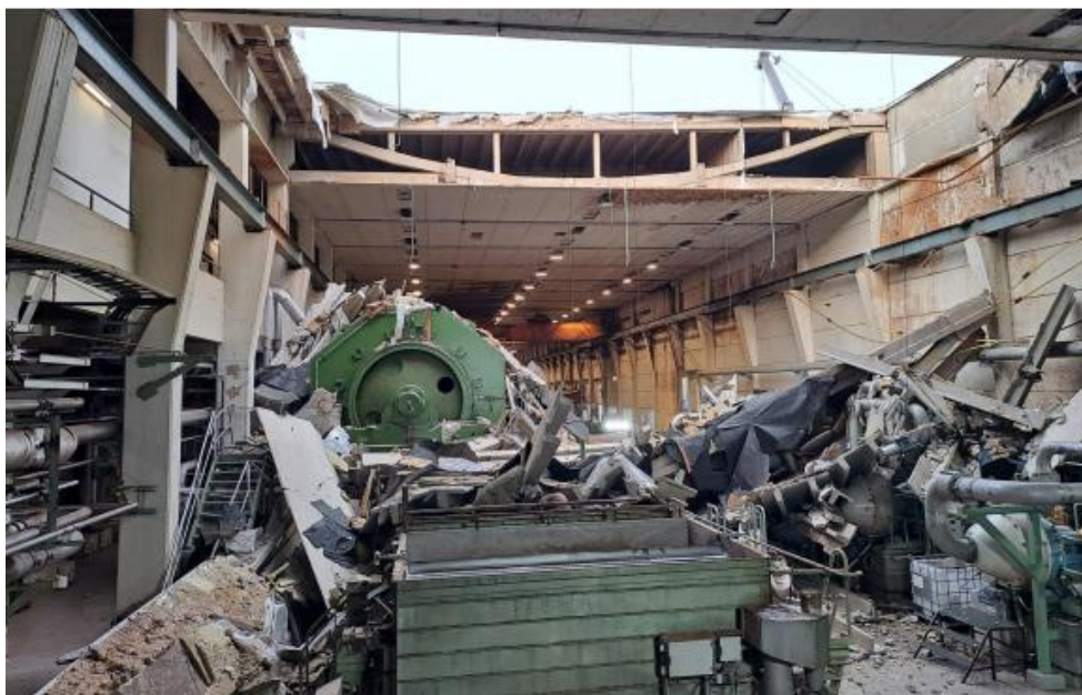
Kuva 8 Onnettomuus aiheutti mittavat vahingot myös viereisessä rakennuksessa.
